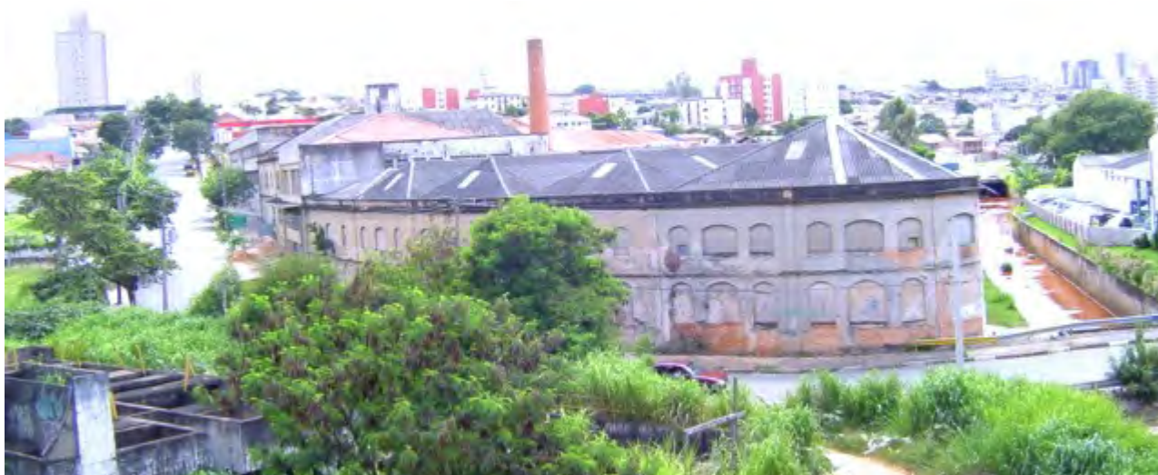
Ao fundo o Cortume Cantusio atualmente; ao lado o córrego Piçarrão. À esquerda da foto, na frente, as ruínas da Estação de tratamento de águas servidas dos Cortumes, atualmente abandonados. O Cortume Cantusio está em vias de ser tombado pelo Patrimônio Histórico do Município de Campinas. Foto 5:
